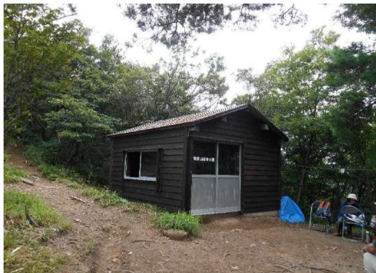
避難小屋 現在は「山の学校鞍掛山」と併設
